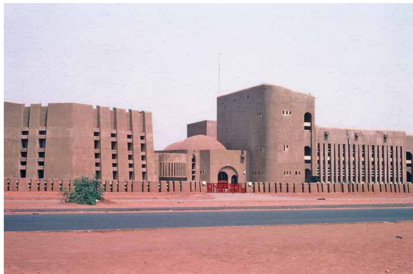
▲ ONERSOL épülete, Niamey, Niger, 1981. Építész: Laszlo Mester de Parajd
