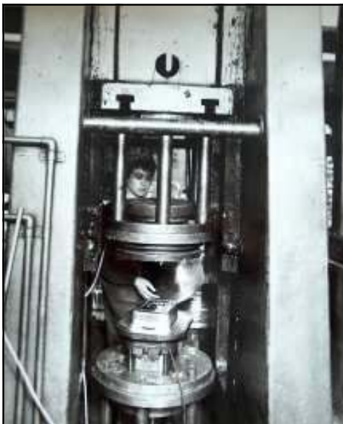
Mélyhúzás – Mályhúzó berendezés a Fémnyomó és Lemezárugyárban – a Jász Múzeum Archívuma
