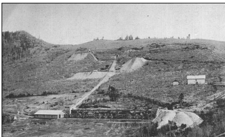
A felsőhrádeki bányák látképe. Fent: a tárók bejáratai, középen a siklópálya, amelyen a szállítás felülről lefelé történt, lent a rakodó és a termelvényt a csetneki vasgyárba szállító kötélpálya feladóállomása.
