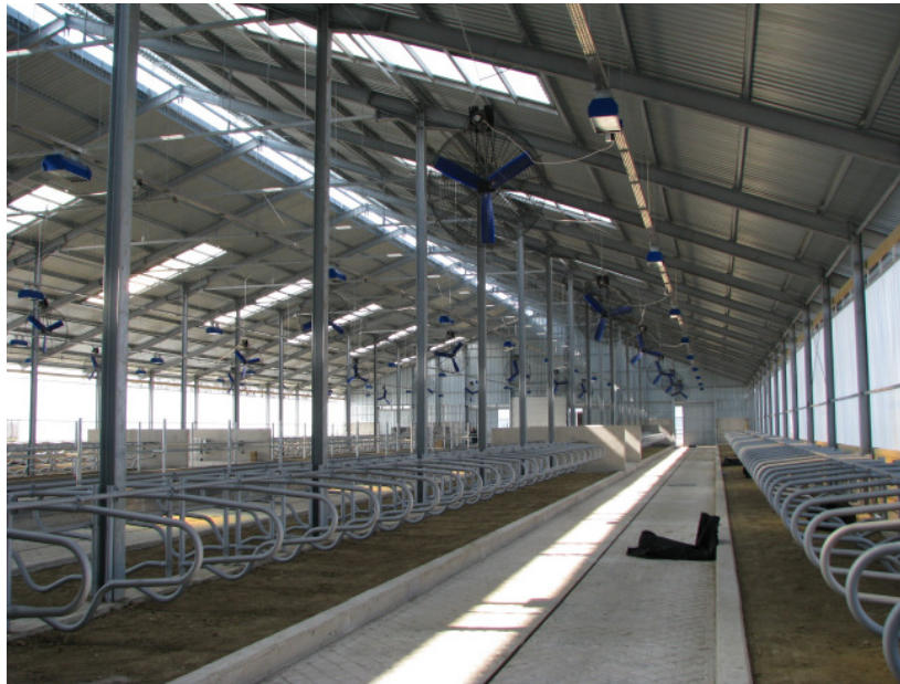
2. kép: Ventilátorok egy készülő istállóban
