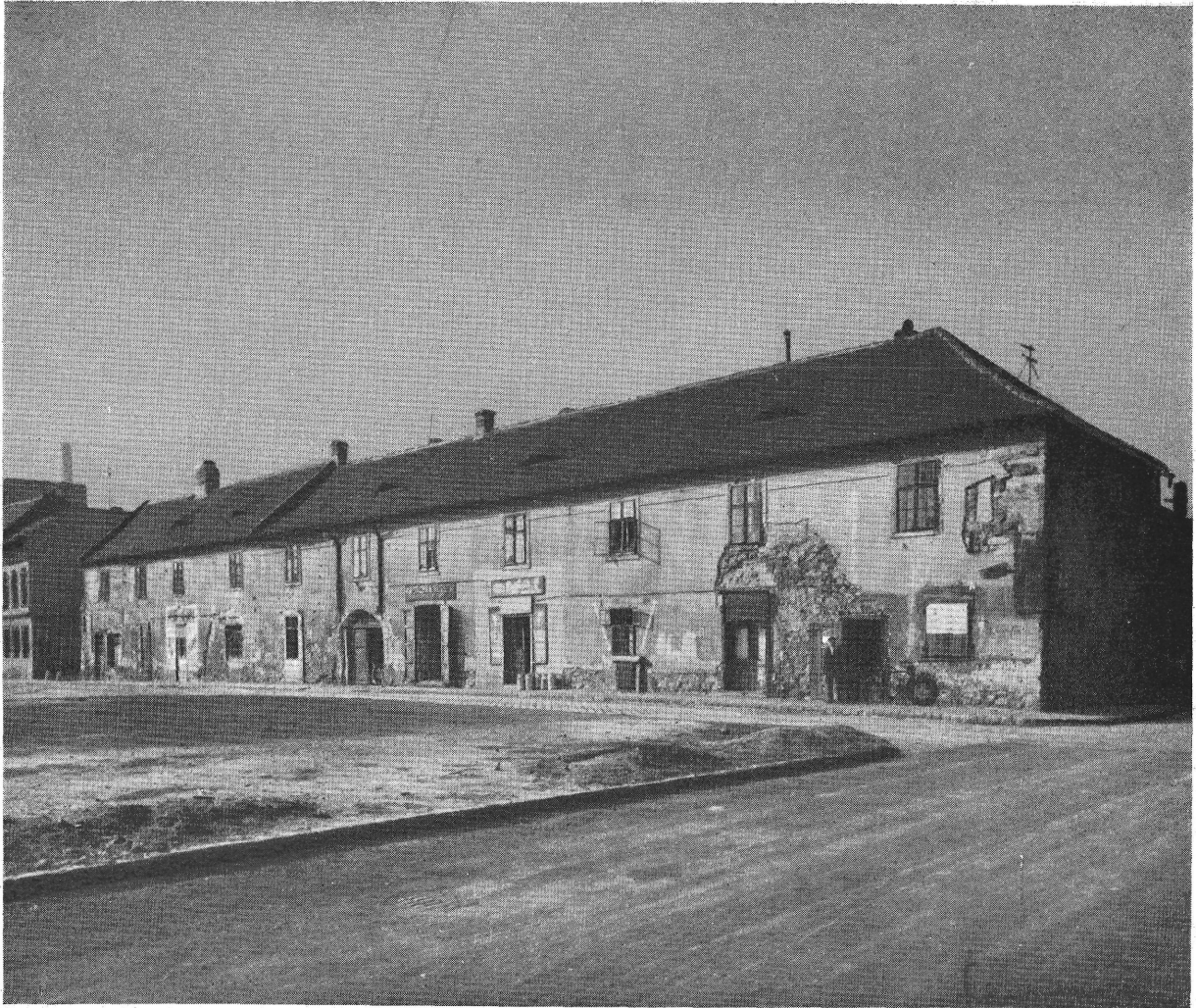
5. kép. A Lajos utca 158. sz. alatti lakóház jelenlegi állapotában
