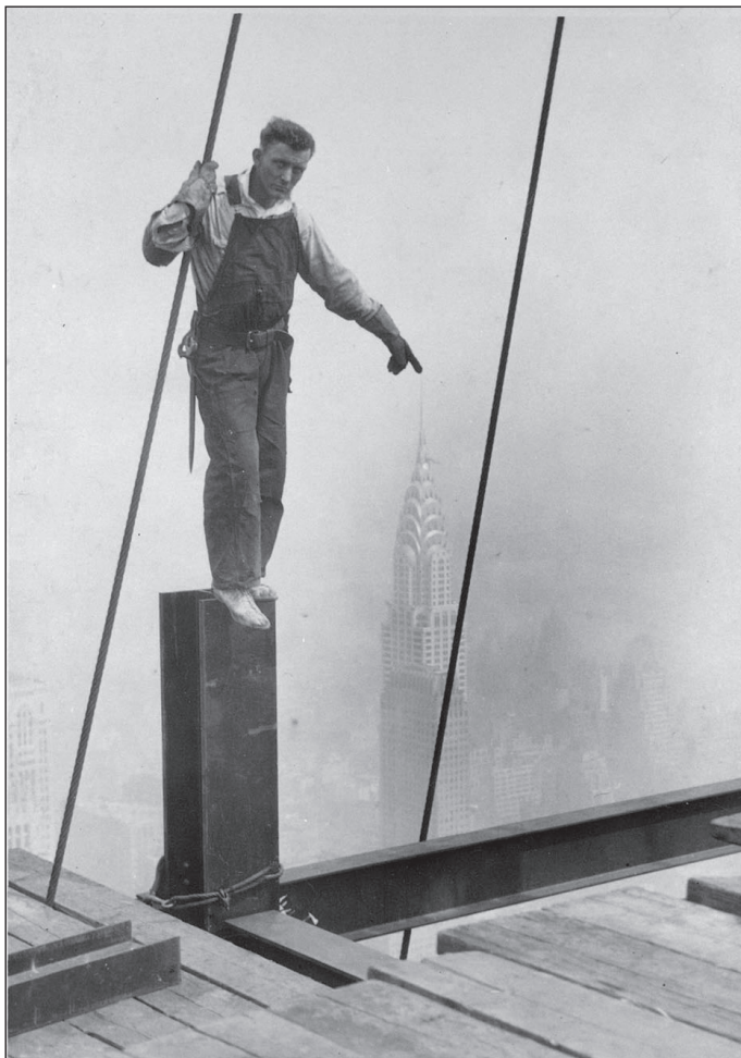
Munkások az Empire State Building építkezésén, 1931
