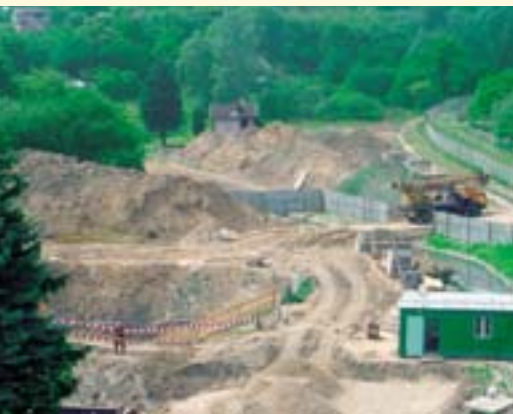
Szczecin: az ISPA által finanszírozott szivattyútelep építése
