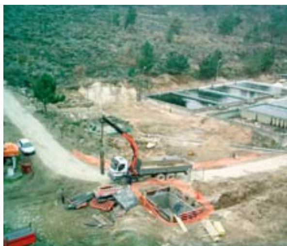
Portugália: szennyvíztisztító telep építése a Kohéziós Alap segítségével
