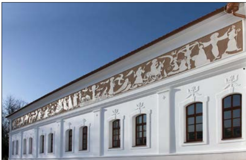
Makoldi Sándor rajzai alapján, sgraffito technikával készült bibliai történeti fríz az épület bal oldali homlokzatán
