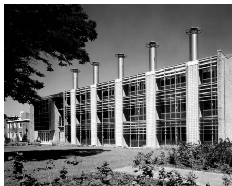
7–8. ábra • A napkémény működési elve, és egy megvalósult példája (BRE épület)
