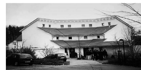
4. ábra • Ikerház Rottweilben: a szoláris tervezési filozófiáról a déli és az északi homlokzat üvegezési aránya árulkodik.
