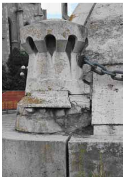
4. kép. Eocén durva mészkő a szobor-építmény alapozásában.
