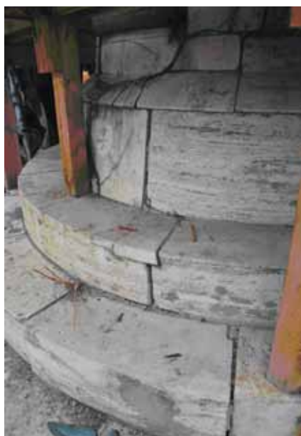
7. kép. Az építményen belül tömör és sávos kváderek váltakoznak.
