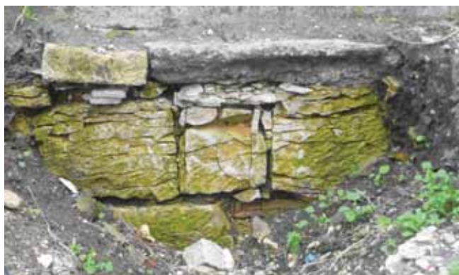
4. kép. Eocén durva mészkő a szobor-építmény alapozásában.
