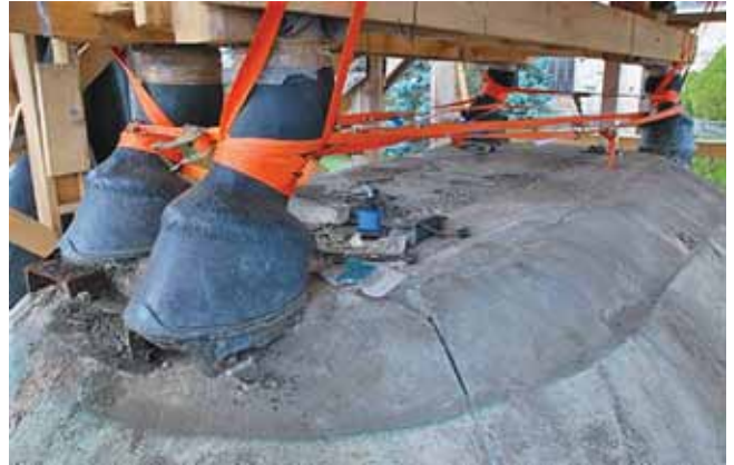
13. kép. A lovasszobrot a kőtalapzathoz rögzítő sín pár.
