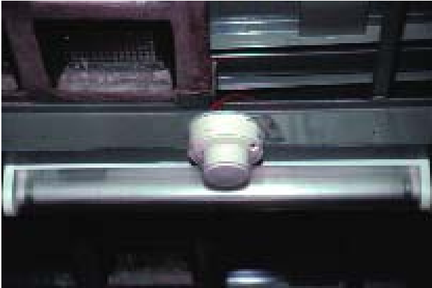
20. kép UV szűrővel ellátott világítótest és füstérzékelő
